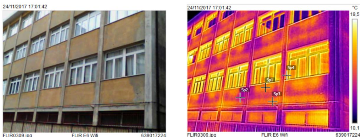
Figura 4.3 – Rilievo termografico della parate Sud-Est
