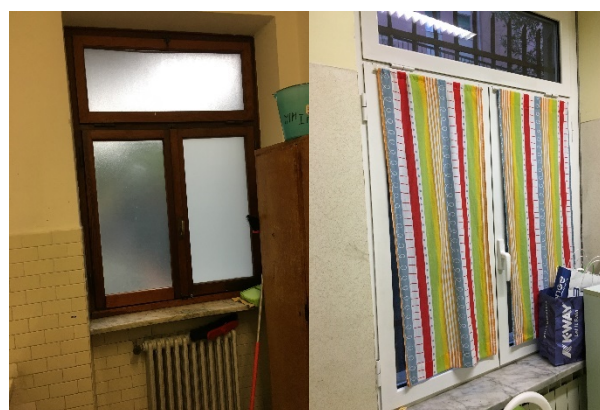
Figura 4.4 - Particolare dei serramenti
