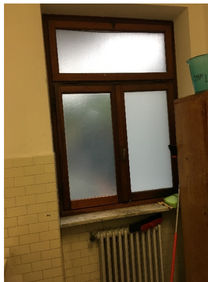
Figura 8.5 - Particolare serramenti da sostituire.
