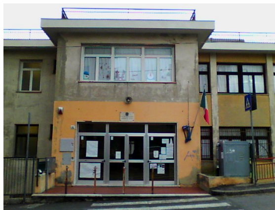
Figura 1.1 - Vista della facciata [esposta a Nord-Ovest]
